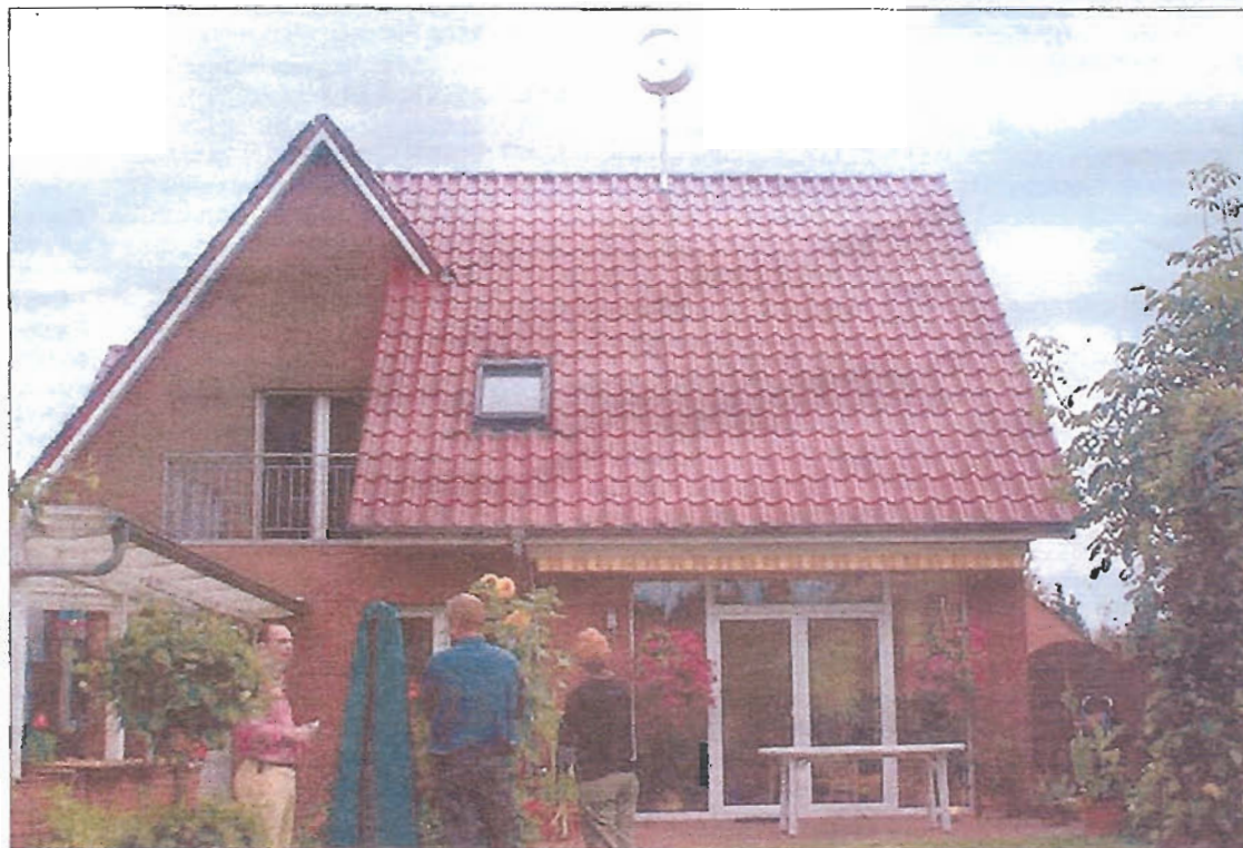
El enflo se coloca en el tejado de las viviendas, de la misma forma que las antenas parabólicas.
